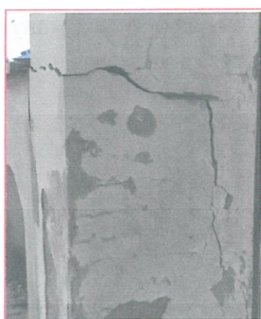
Pęknięcia elementów konstrukcyjnych, uszkodzenia tynku spowodowane zawilgoceniem, zarysowania i odchylenia od pionu
