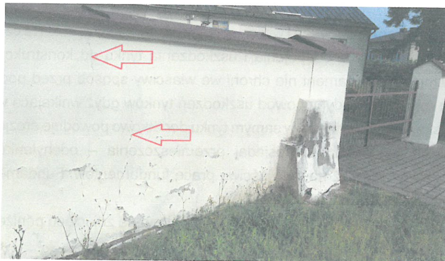
Uszkodzenia tynku, drobne zarysowania i zawilgocenia
