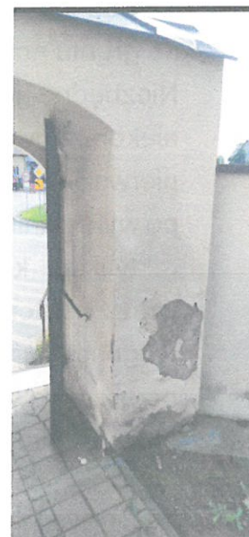
Zawilgocenia tynku i odspojenia, drobne zarysowania ograniczające się do wierzchnich warstw konstrukcji muru.
