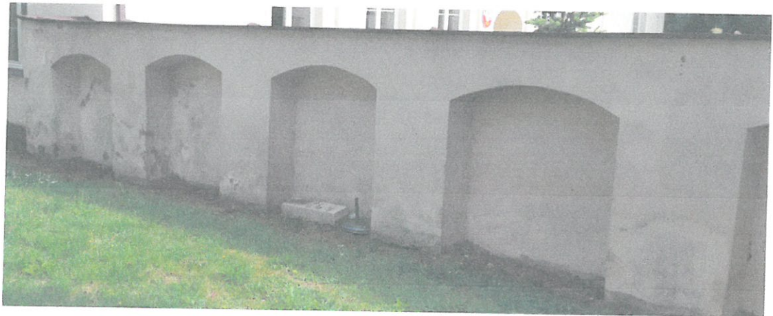
Zawilgocenia tynku i odspojenia, drobne zarysowania
