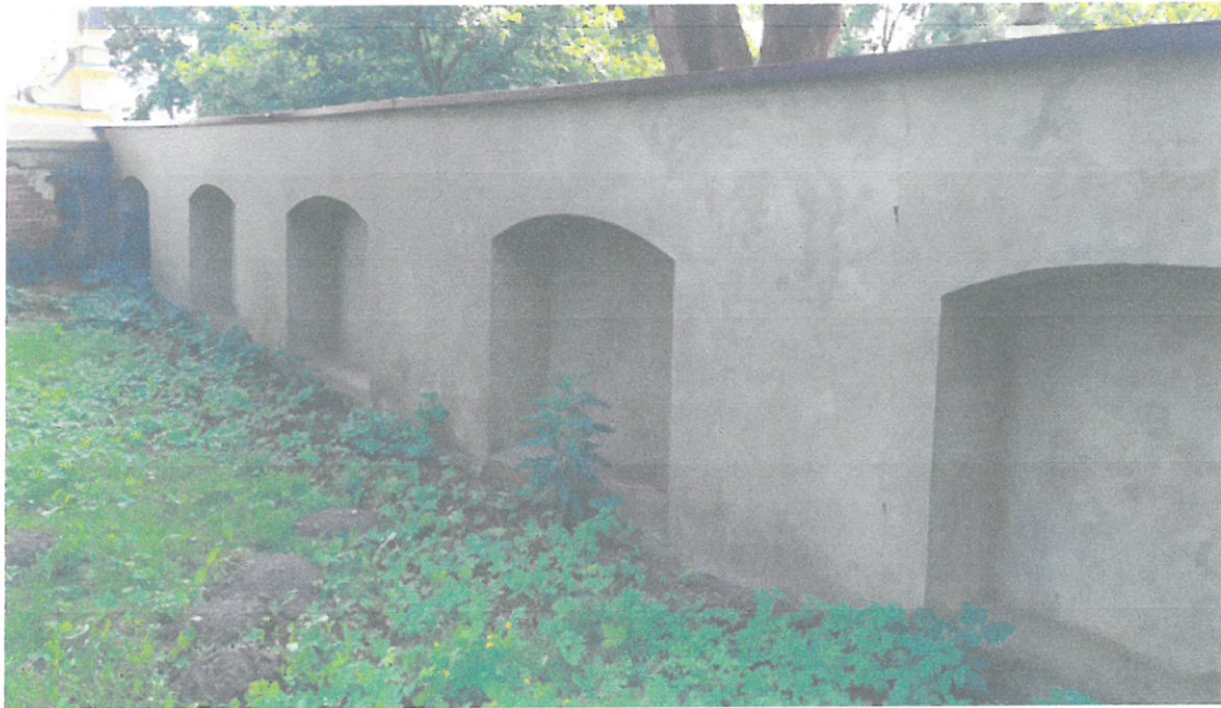
Widok muru od podwórka Kościoła: drobne uszkodzenia, zawilgocenia tynku.
