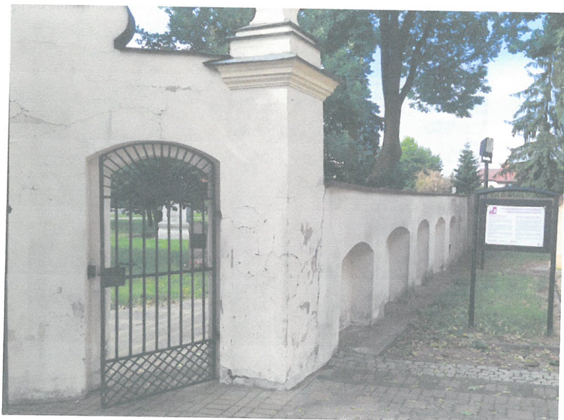
Uszkodzenia tynku spowodowane zawilgoceniem, zarysowania i odchylenia od pionu
