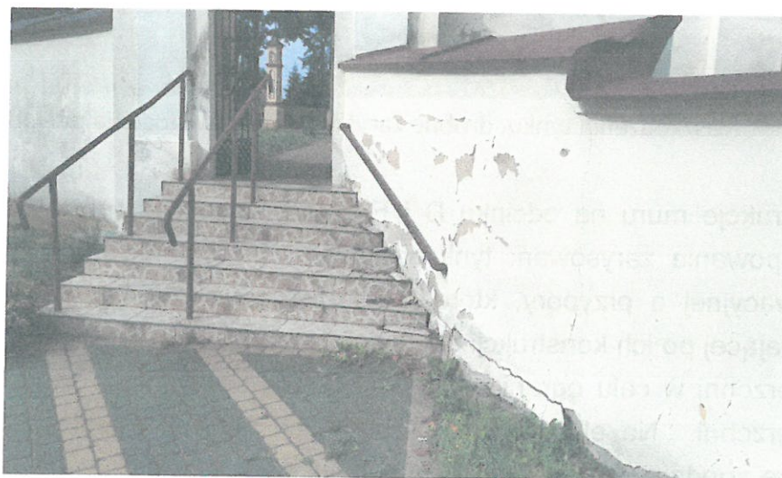
Odpojenie tynku w strefie cokołowej, uszkodzenia wierzchniej faktury, zawilgocenia.
