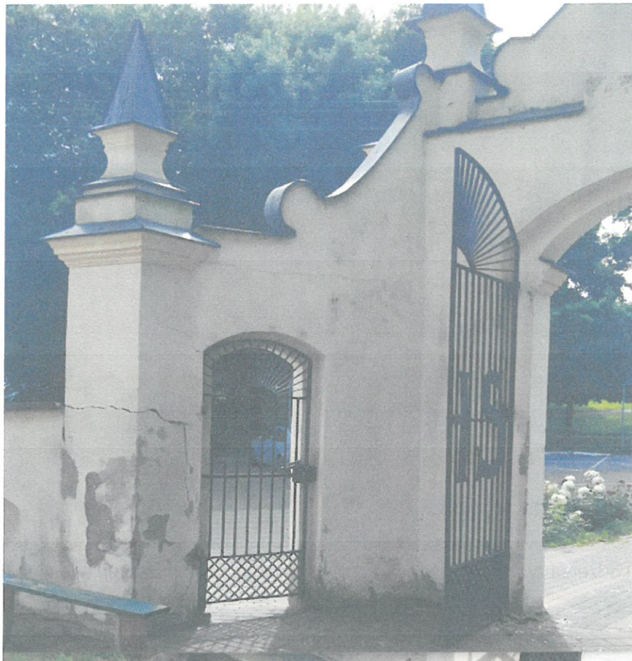
Pęknienia elementów konstrukcyjnych, uszkodzenia tynku spowodowane zawilgoceniem, zarysowania i odchylenia od pionu
