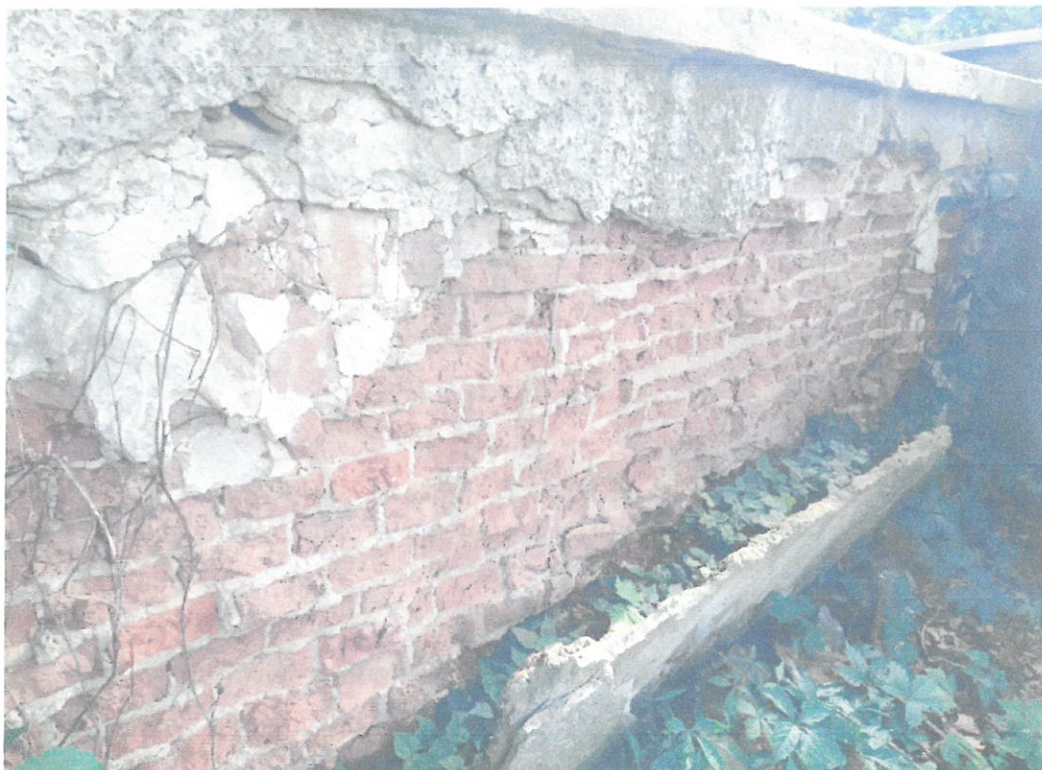
Widok uszkodzonej elewacji wewnętrznej muru ogrodzeniowego, rozwarstwienia cegieł z których mur ogrodzeniowy został wykonany.
