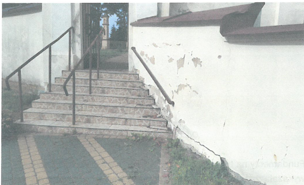
Odspojenie tynku w strefie cokołowej, uszkodzenia wierzchniej faktury, zawilgocenia.
