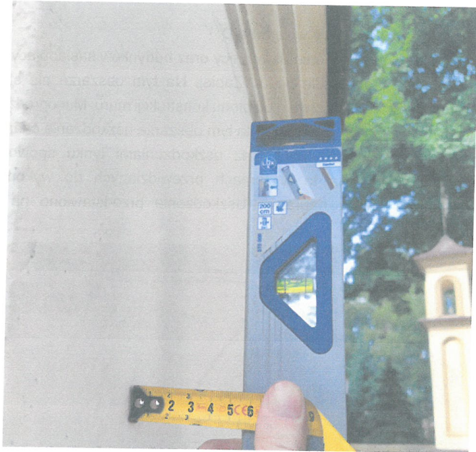
Odchylenie od pionu około 6cm
