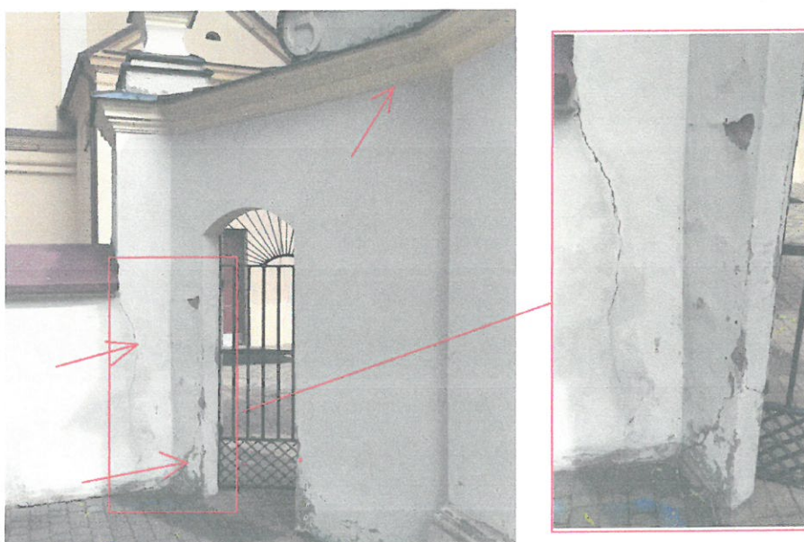
Zarysowanie konstrukcji muru, zawilgocenia i uszkodzenia tynku spowodowane wilgocią.
