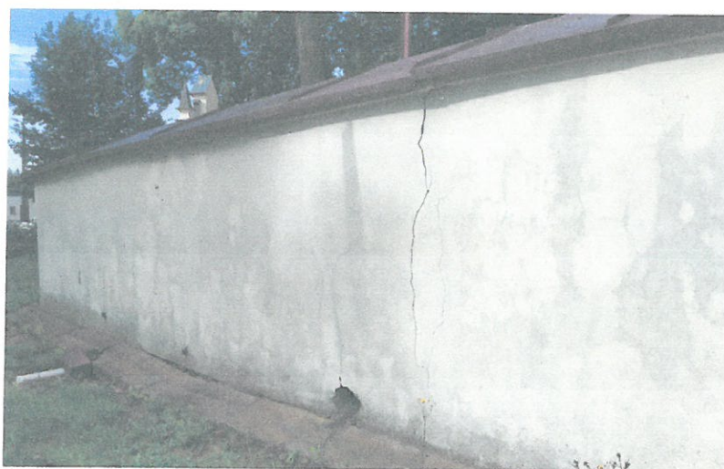
Zarysowania konstrukcyjne muru, zarysowania towarzyszy odchylenie od pionu.
