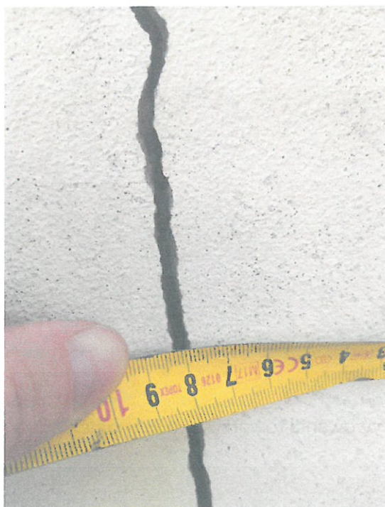
Pęknięcia muru ogrodzeniowego, szerokość dochodzi lokalnie do 10mm
