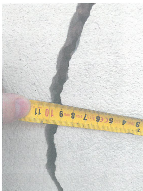
Pęknięcia muru ogrodzeniowego, szerokość dochodzi lokalnie do 10mm
