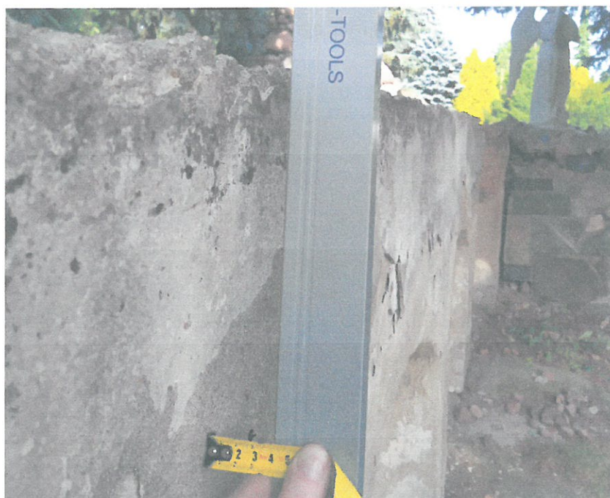
Odchylenia od pionu konstrukcji muru – około 4cm
