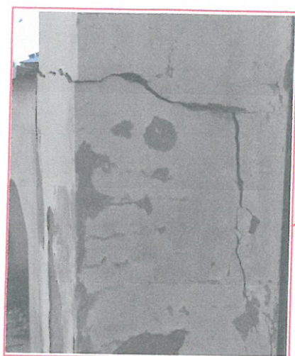
Pęknięcia elementów konstrukcyjnych z przemieszczeniem, uszkodzenia tynku spowodowane zawilgoceniem, zarysowania i odchylenia od pionu
