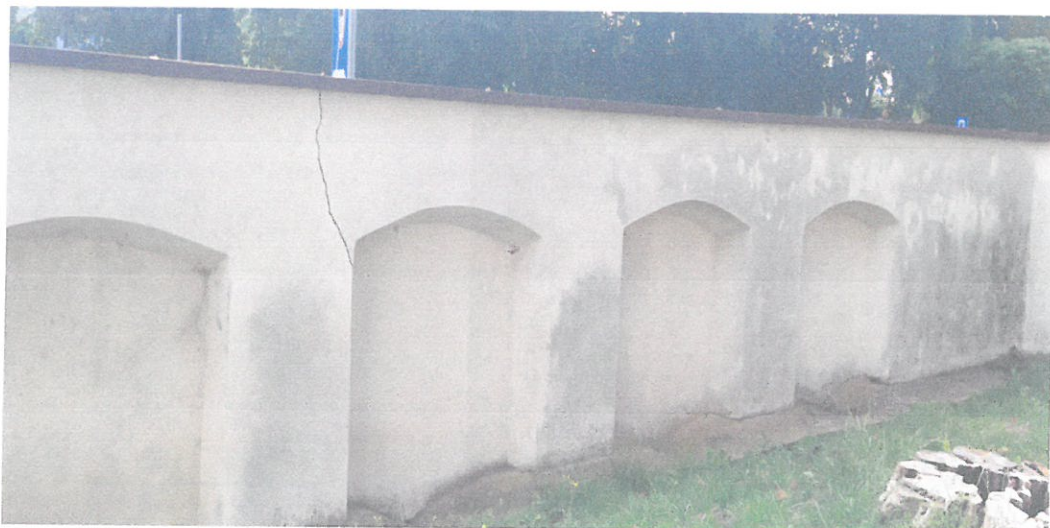
Widok muru od podwórka, konstrukcja muru zarysowana, odchylona od pionu, warstwa wierzchnia tynku z uszkodzeniami spowodowanymi zawilgoceniem i korozją biologiczną.
