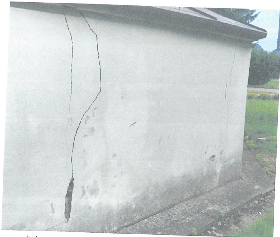
Zarysowania konstrukcyjne muru, zarywowaniai towarzyszą odchylenia od pionu.
