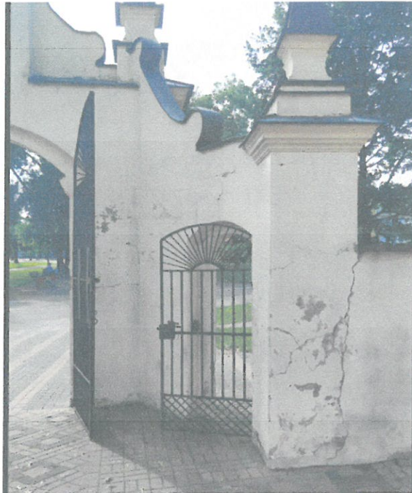
Uszkodzenia tynku spowodowane zawilgoceniem, zarysowania i odchylenia od pionu
