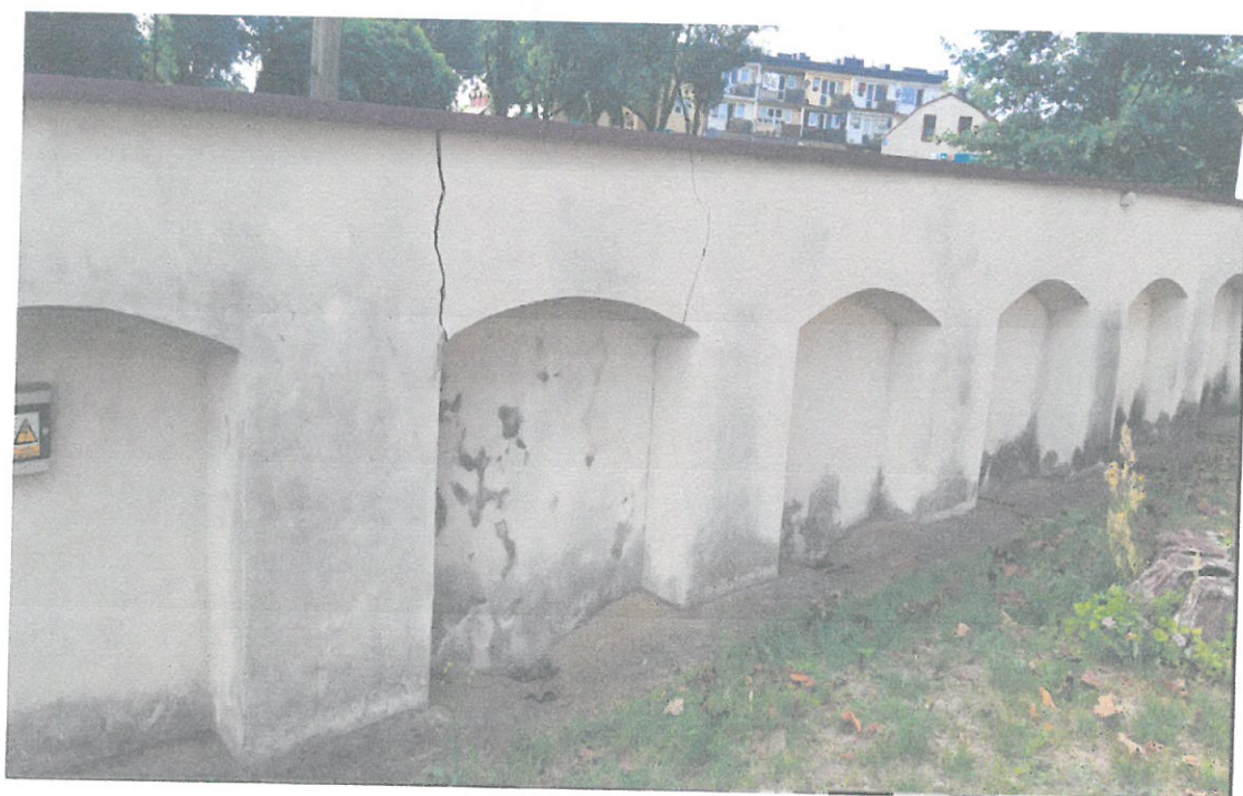
Zarysowania konstrukcyjne muru, zarywowania towarzyszą odchYLENIA od pionu.
