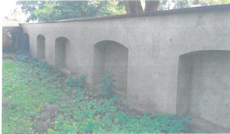
Widok muru od podwórka Kościoła – dobry stan techniczny, drobne uszkodzenia i zawilgocenia
