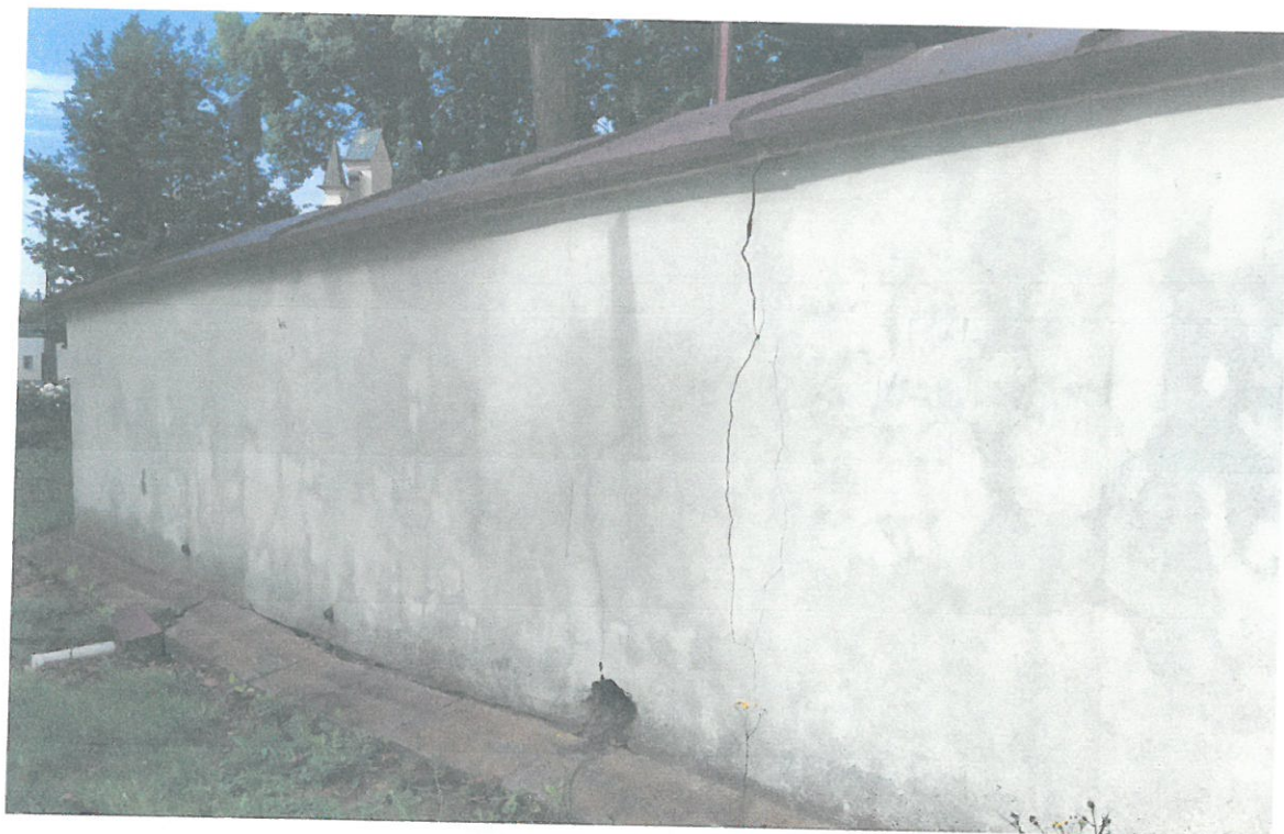
Zarysowana i odchylona od pionu konstrukcja muru
