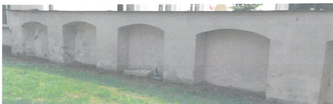
Zawilgocenia tynku i odspojenia, drobne zarysowania.
