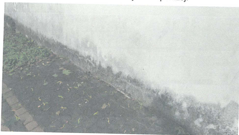
Zawilgocenia oraz towarzysząca im korozja biologiczna w strefie cokołowej
