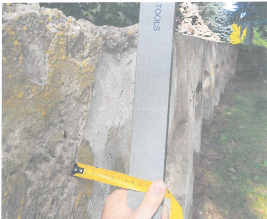
Odchylenia od pionu konstrukcji muru – około 8cm
