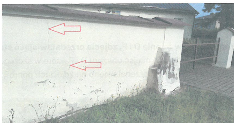
Uszkodzenia tynku, drobne zarysowania i zawilgocenia przypory
