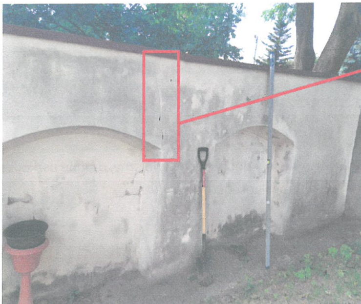
Widok muru od podwórka Kościoła – stan techniczny zadowalający, drobne uszkodzenia, zawilgocenia tynku oraz zarysowania wymagające naprawy, jednak bez konieczności wzmocnienia fundamentów.
