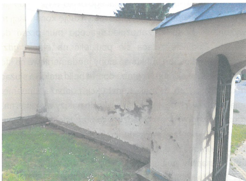
Zawilgocenia tynku i odspojenia, drobne zarysowania ograniczające się do wierzchnich warstw konstrukcji muru.
