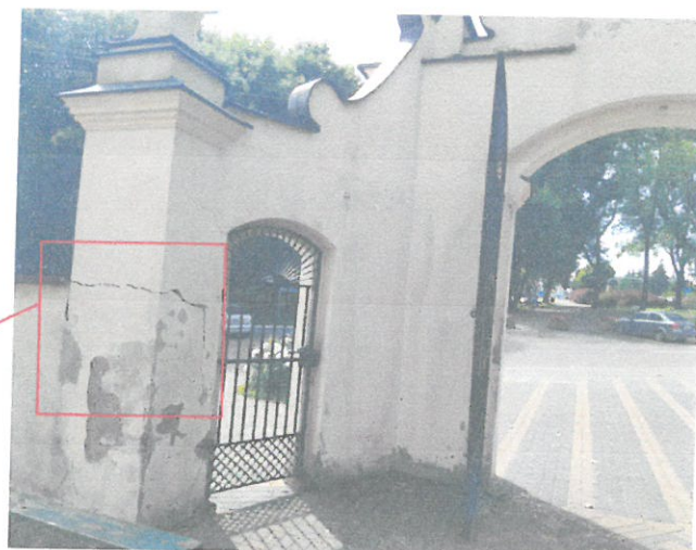
Pęknięcia elementów konstrukcyjnych z przemieszczeniem, uszkodzenia tynku spowodowane zawilgoceniem, zarysowania i odchylenia od pionu
