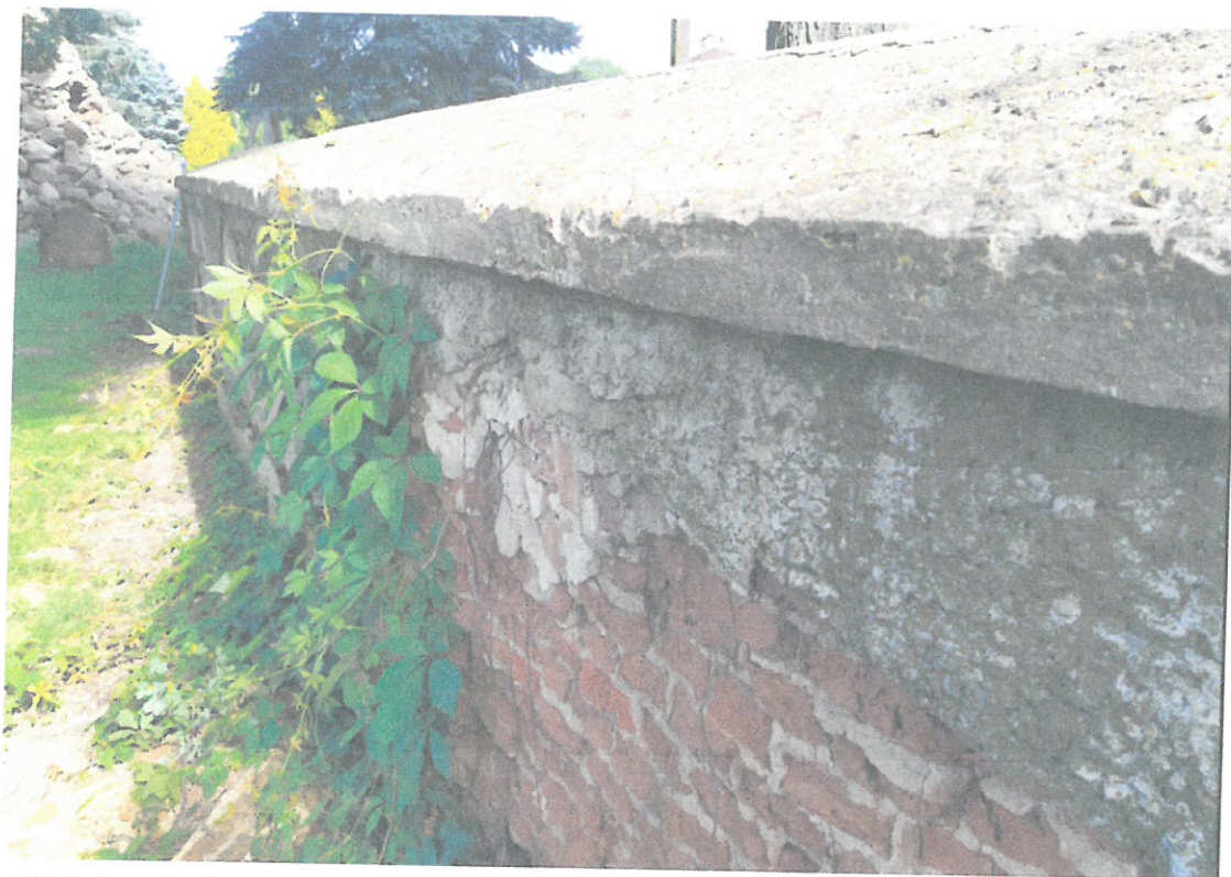
Widok uszkodzonej elewacji wewnętrznego muru ogrodzeniowego, rozwarstwienia cegieł z których mur ogrodzeniowy został wykonany.
