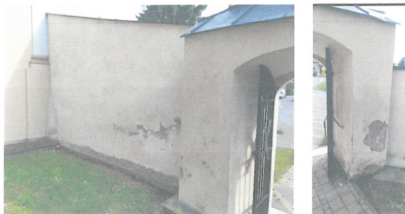
Zawilgocenia tynku i odspojenia
