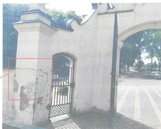
Pęknięcia elementów konstrukcyjnych, uszkodzenia tynku spowodowane zawilgoceniem, zarysowania i odchylenia od pionu
