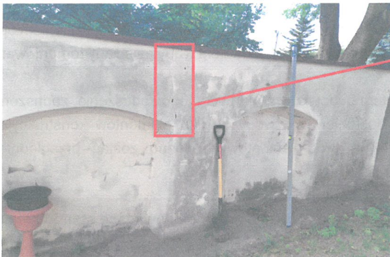
Widok muru od podwórka Kościoła – dobry stan techniczny, drobne uszkodzenia, zawilgocenia tynku oraz zarysowania wymagające naprawy, jednak bez konieczności wzmocnienia fundamentów.
