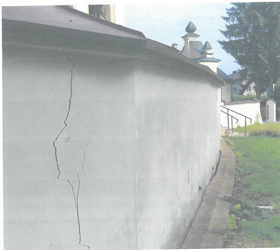
Zarysowania konstrukcyjne muru, zarywowaniai towarzyszą odchylenia od pionu.
