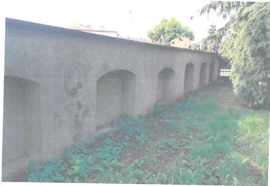
Widok muru od podwórka Kościoła – dobry stan techniczny, drobne uszkodzenia, zawilgocenia tynku.
