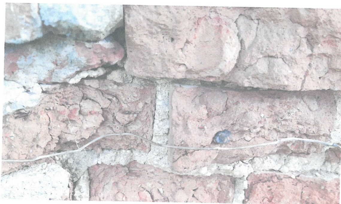
Struktura cegły – bardzo złej jakości. Nie ma gwarancji przyczepności tynku do takiego podłoża bez wzmocnienia elementami stalowymi.
