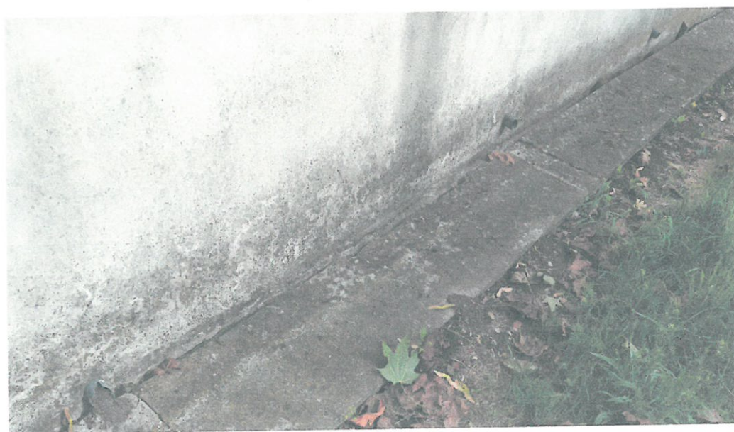
Zabrudzenia i korozja biologiczna spowodowana ropzyskiwaniem się wody. Wilgotności ściany nie mierzono jednak tynk nie wykazuje oznak uszkodzeń (poza przebrwieniami i nalotem organicznym) spowodowanych zawilgoceniem.
