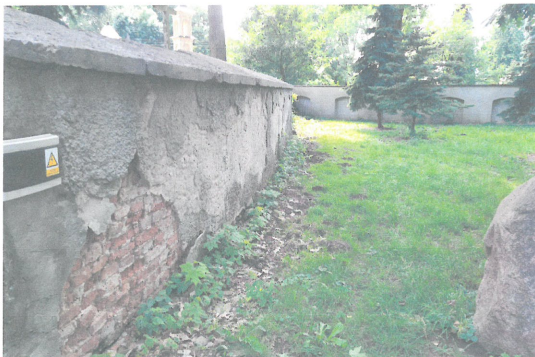
Widok uszkodzonej elewacji wewnętrznej muru ogrodzeniowego
